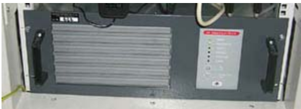
Esempio di sistema UPS per server
