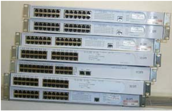
Esempi di hub e switch Ethernet
