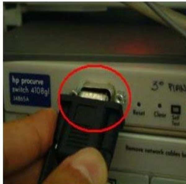
Interconnessione del cavo seriale all'apparato attivo
