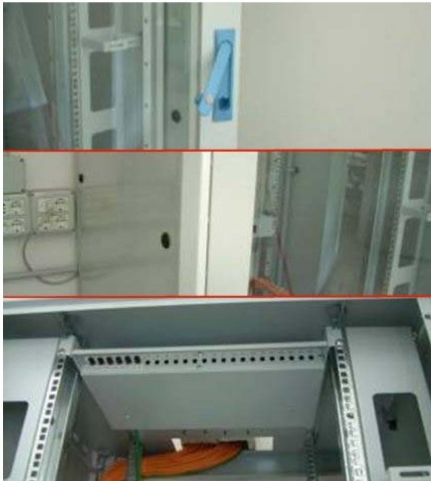
Analizziamo in dettaglio la costituzione dell'armadio. Innanzitutto, possiamo notare la porta-finestra, dotata di serratura di sicurezza, posta sul lato frontale. Inoltre, l'armadio è fornito di alcune pareti laterali amovibili, utili per consentire un più comodo accesso all'interno dell'armadio. Spesso, anch'esse sono dotate di una serratura a chiave. All'estremità superiore è presente un cassetto ottico, all'interno del quale sono intestate alcune coppie di fibre ottiche.
