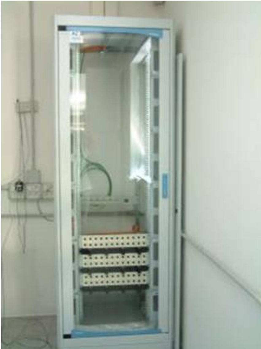
Panoramica di un armadio rack
