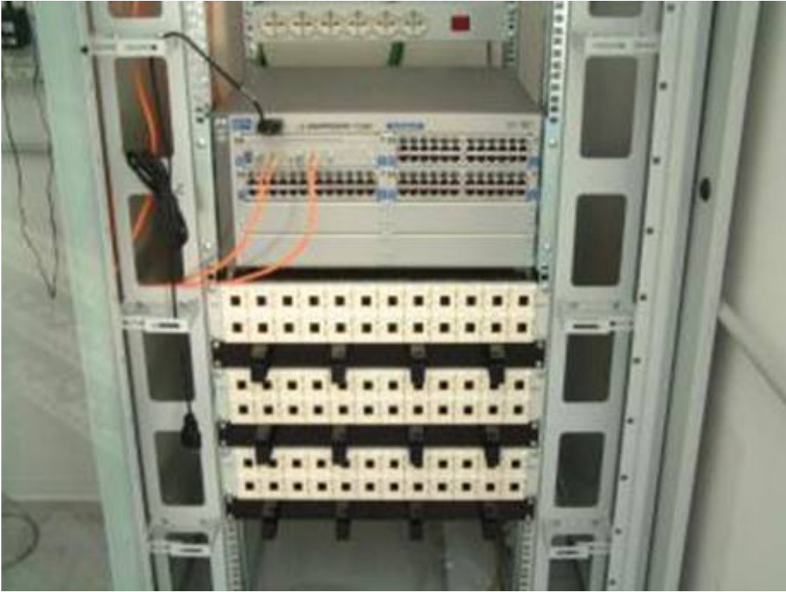
Switch installato all'interno dell'armadio
