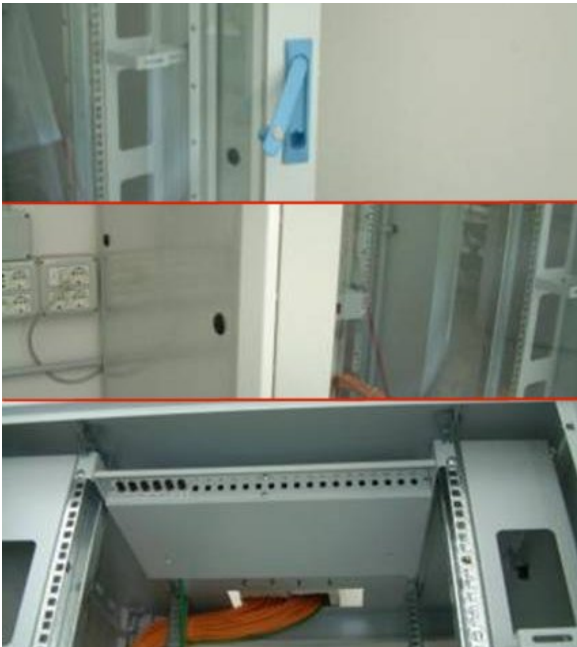
Porta frontale di un armadio rack, porta laterale con serratura laterale e cassetto ottico
